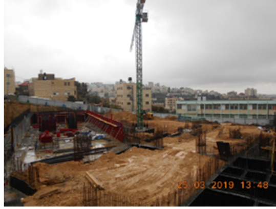
الرافعة الخاصة بالمشروع والتي تم تركيبها وتشغيلها في مبنى 1 و 3 وجزء من المبنى 2
