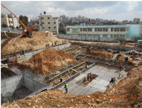
أعمال اساسات قاعدة خزان المياه في البناية 3
